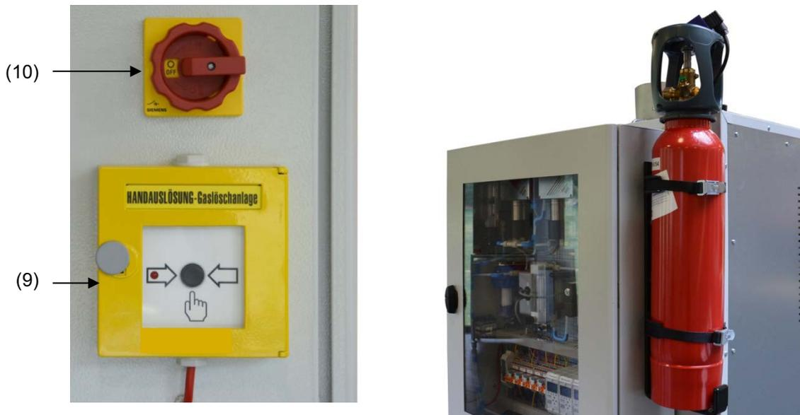
Interrupteur principal du système de détection de gaz (10) et déclenchement manuel du dispositif de suppression d'incendie (9) (d'exemple d'illustration)
