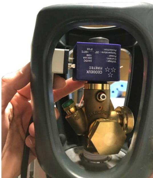
Figure 32: Connexion du connecteur de bobine
