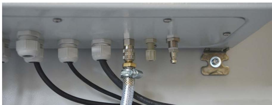
Figure 24: Raccord pour gaz inerte en bas du module de sécurité
