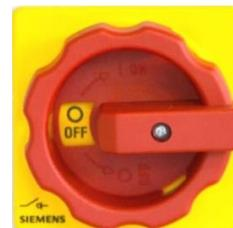
Figure 11: Interrupteur principal (10) du système de détection de gaz (Position OFF)
