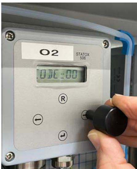
Figure 44: Saisie du code pour le menu de service (exemple : au capteur d'O<sub>2</sub>)
