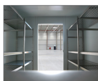
Parois intérieures et plafond en acier inoxydable avec étagères pour charges lourdes
