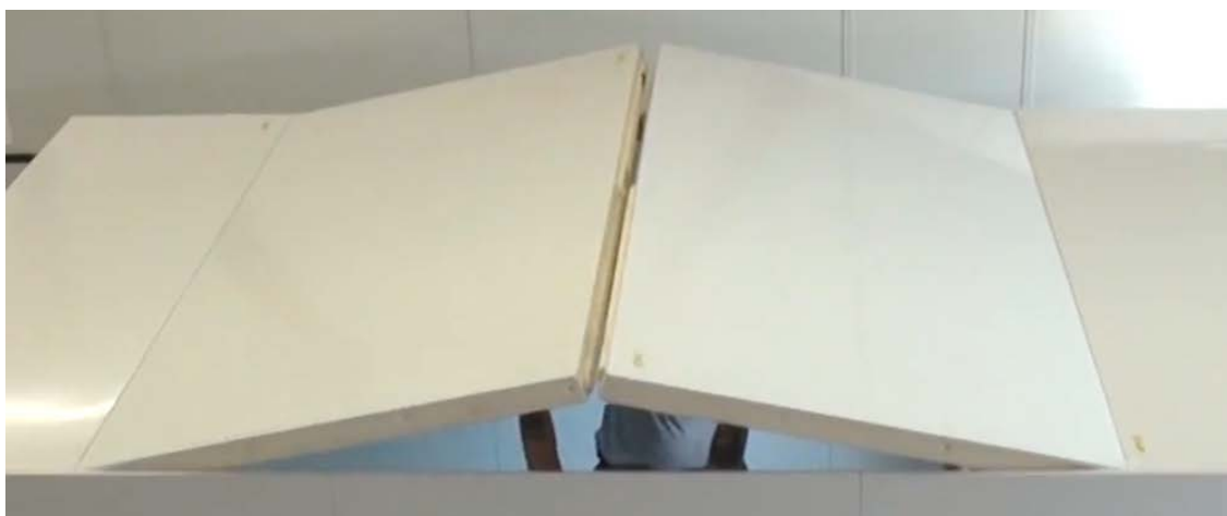
Figure 15 : Mise en place des derniers éléments de plafond
