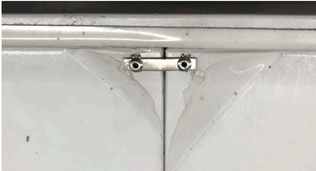
Figure 16 : Raccordement des éléments de plafond
