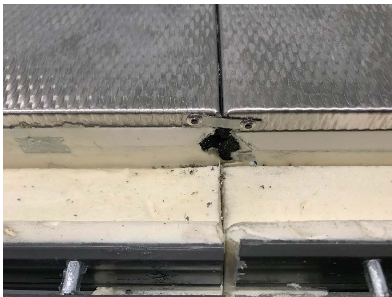
Figure 8 : Connexion des éléments de plancher
