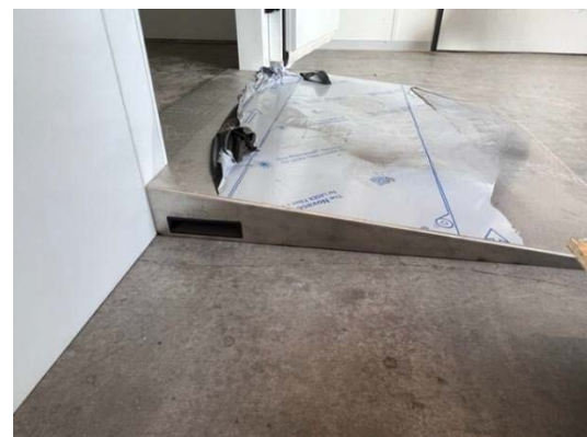
Figure 23 : Montage de la rampe de seuil de porte
