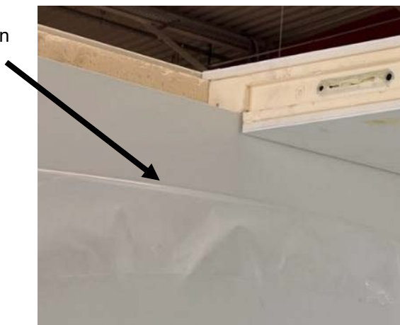
Figure 10 : Film de protection partiellement retiré lors du montage des éléments de paroi
