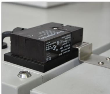
Elektromechanische Türverriegelung gesteuert über Zeitprogramm oder manuellen Betrieb
