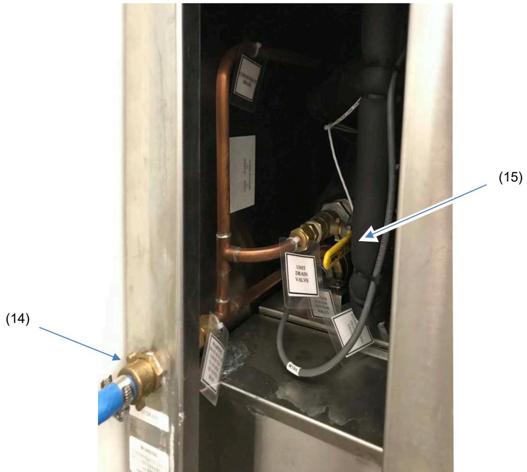
Abbildung 12: Positionen des Abwasseranschlusses (14) und Abwasserventils (15)
